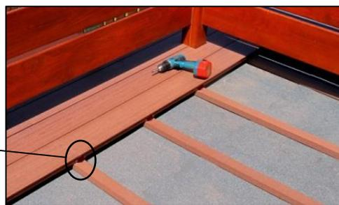
Počáteční a koncové prkno se připevňuje k podkladovému rámu napřímo vruty přes boční drážku. Jedním vrutem zafixujete stejným způsobem rovněž každé další prkno v polovině jeho délky.
